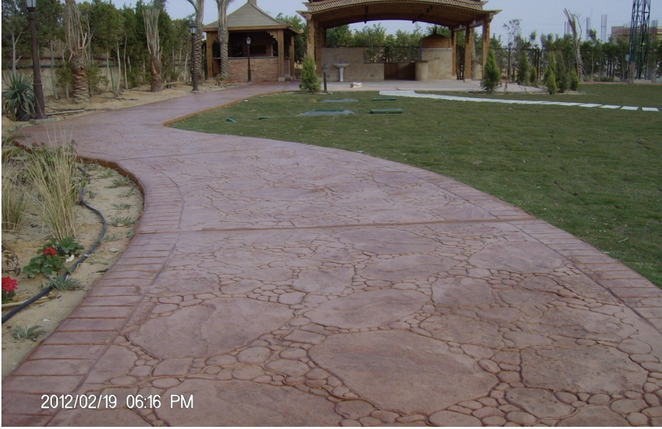
شكل رقم 2 : يوضح نوع من الخرسانة المطبوعة
