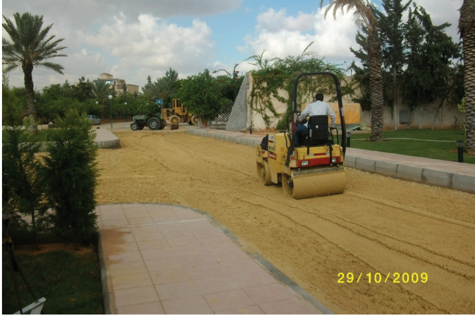
شكل رقم 6 : يوضح مرحلة تجهيز الأرضية
