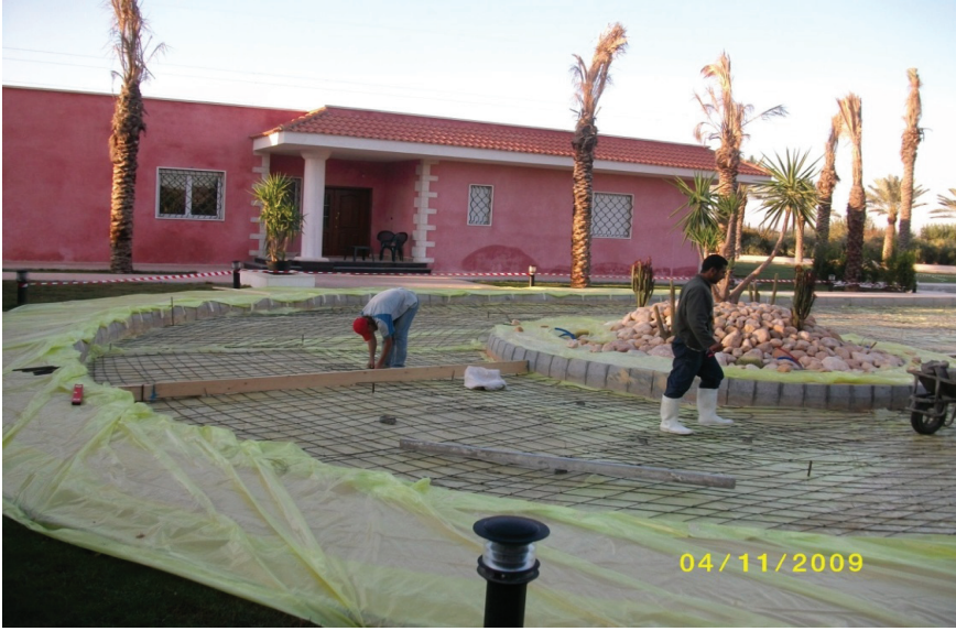
شكل رقم 8 : يوضح فرش شبكة من الحديد
