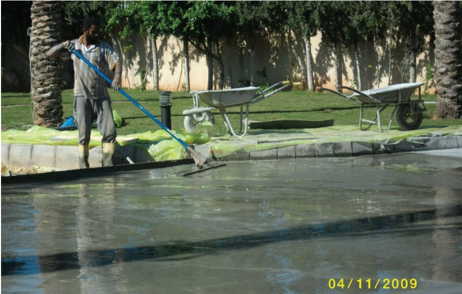
شكل رقم 9 : يوضح صب الخرسانة
