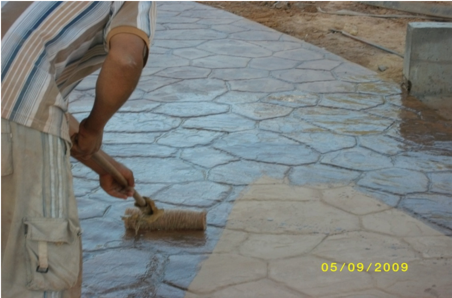
شكل رقم 11 : يوضح وضع طبقة لامعة
