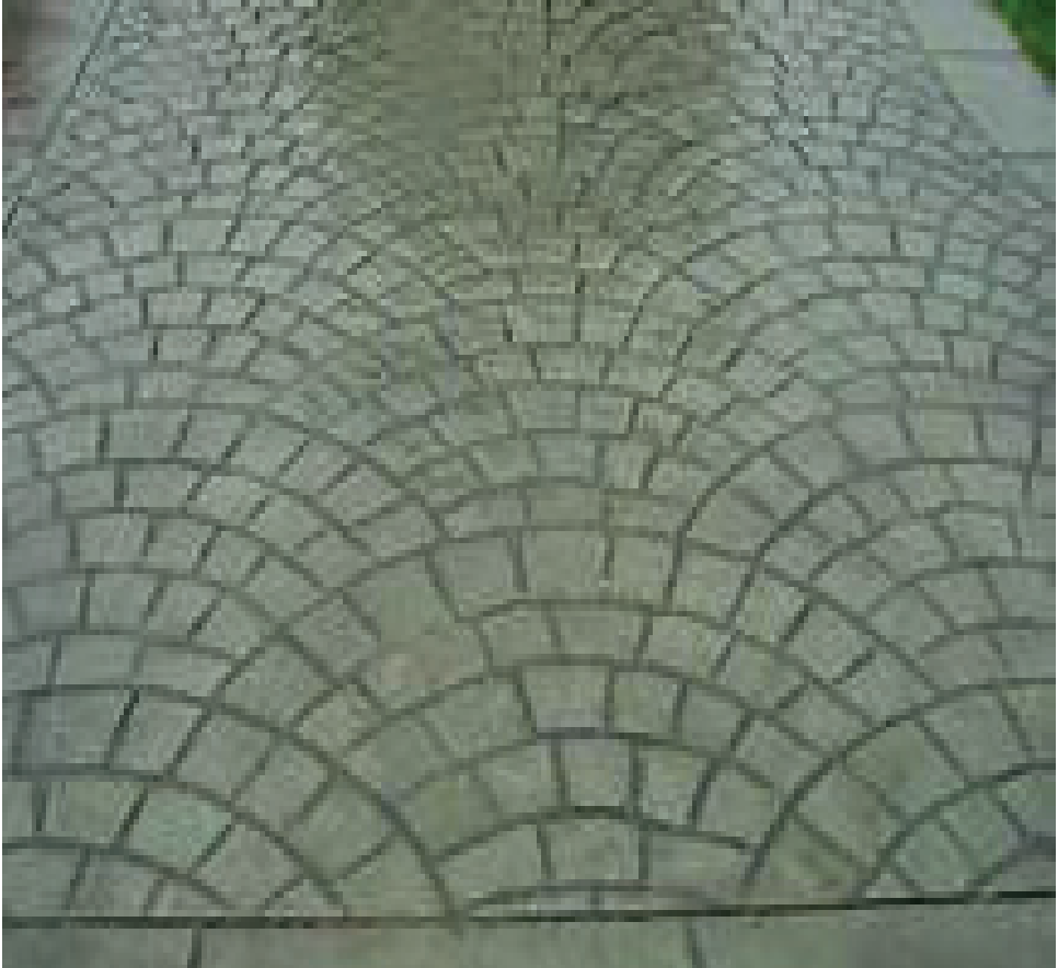
شكل رقم 1 : يوضح نوع من الخرسانة المطبوعة
