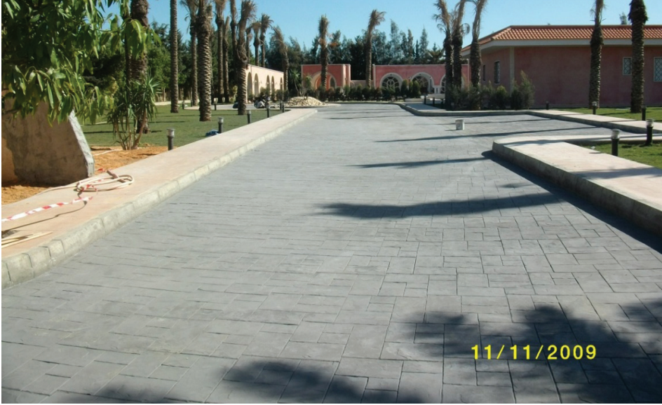
شكل رقم 10 : يوضح الطباعة
